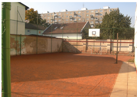
Hřiště v prostorách oddělení před rekonstrukcí
