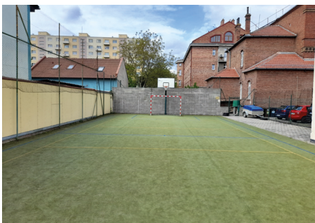
Víceúčelové hřiště po rekonstrukci
